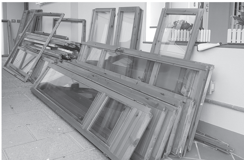
Figura 3. Serramenti in legno con vetro singolo a seguito di una sostituzione e pronti per essere riciclati. [Casafinestra, 2018].
