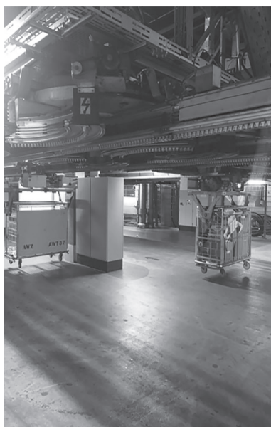
Figura 2. A sinistra: tecnologia di movimentazione AGV per il materiale pesante presso l'Ospedale Papa Giovanni XXIII di Bergamo. A destra: Sistema di trasporto di materiale sospeso e direzionato da binari presso l'Ospedale Universitario di Aachen (D) [Foto dell'autore].
