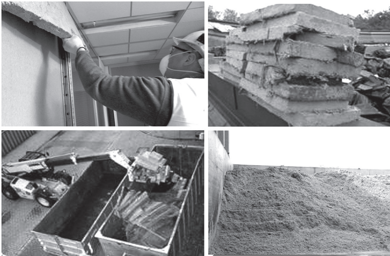
Figura 2. Ciclo di dismissione dei pannelli in lana minerale [Foto delle autrici].
