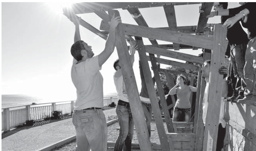
Figura 4. Vesima: il cantiere (foto Chiara Carraro).
